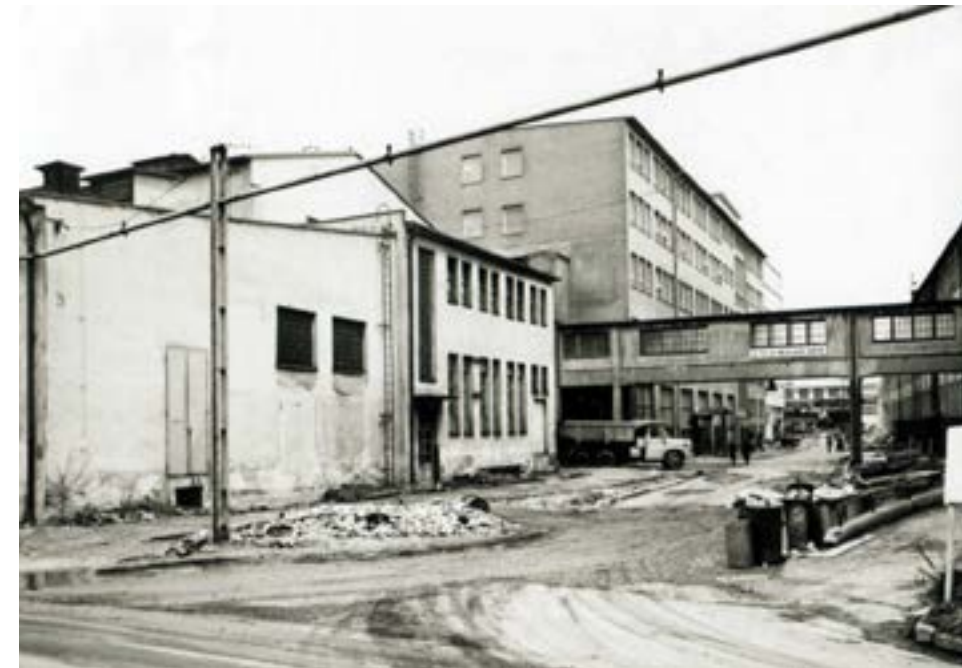
Budova č. 45 se spojovacím mostem (vpravo). Původně byla budova určena pro výrobu zbraní, které posléze nahradila produkce obráběcích strojů. (1976) Building No. 45 with connecting bridge (right). The building was originally designed for making weapons. It was replaced by production of machine tools. (1976)
