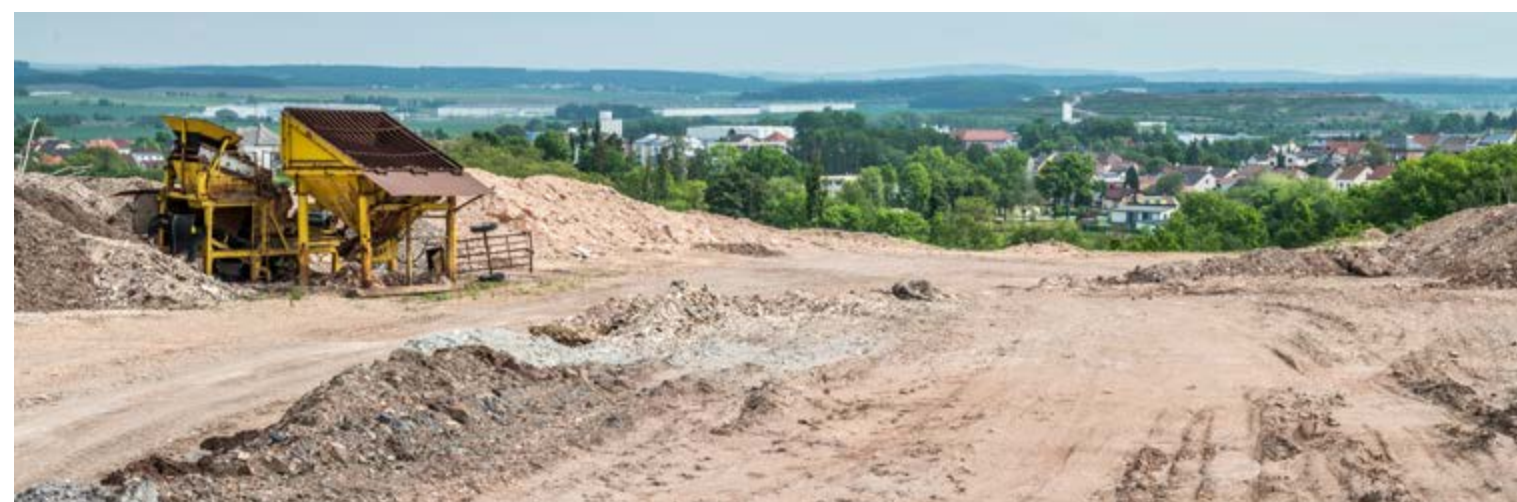
Zbýlé budovy dolu a práce na odvalu v současnosti.
