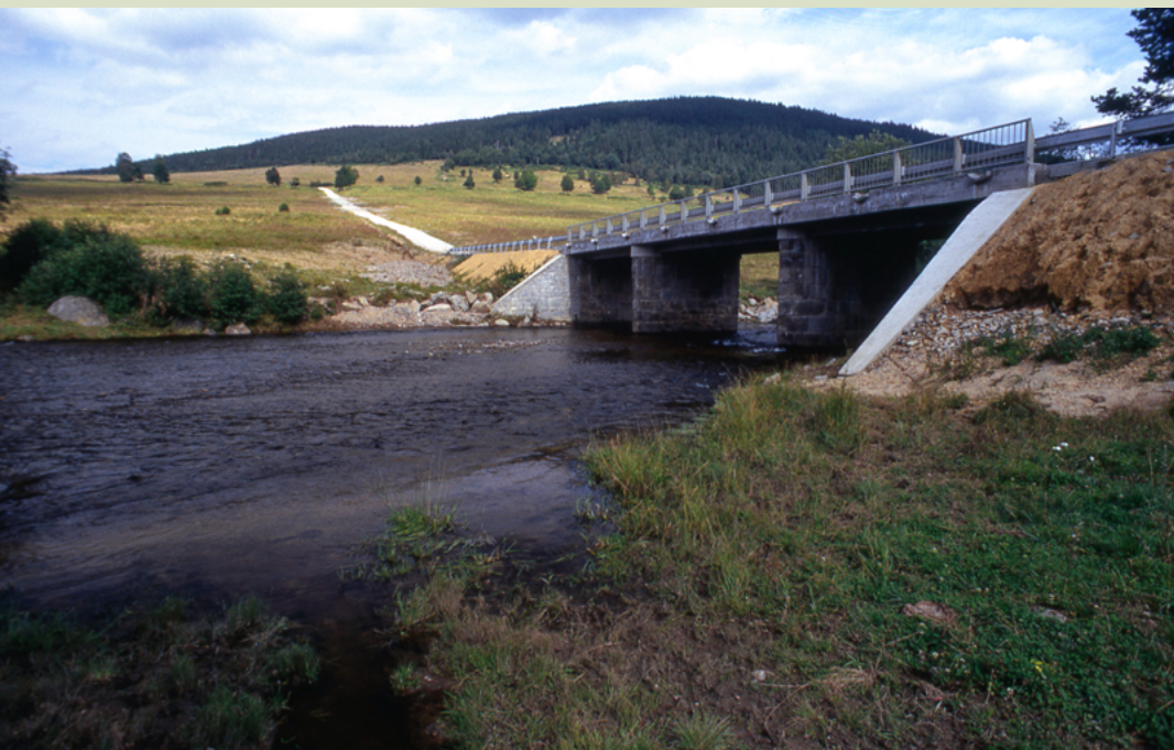
červenec 1991 / Na samém konci osmdesátých let 20. století byl opraven, avšak v současnosti je opět v rekonstrukci
