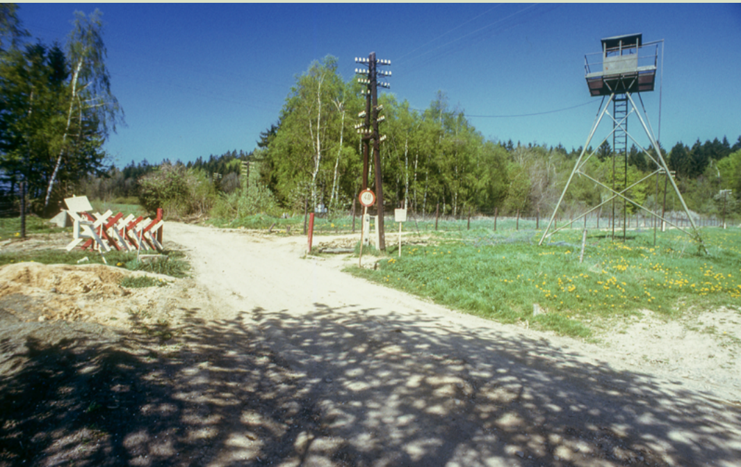
květen 1990 / Nejtýpčtějším zabezpečením ochrany státní hranice byl však drátěný plot, nad kterým vystupovala pozorovatelná. Vojenské věže byly rozmístěny podél plotu tak, aby bylo vidět z jedné na druhou.
