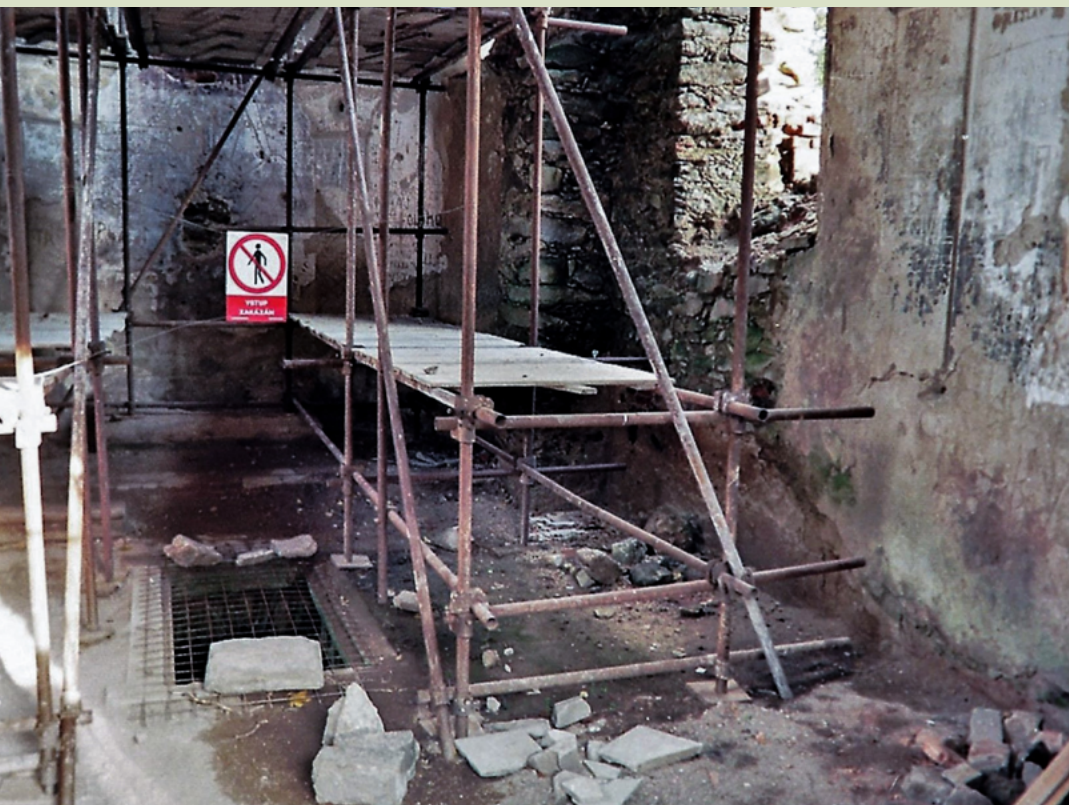
červenec 1998 / Začátek obnovy kaple sv. Kříže
