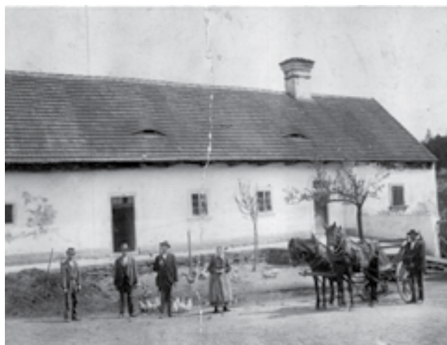
Původní stavení, začátek 20. století
