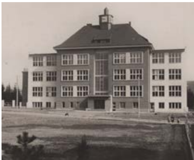
Původní obecná a měšťanská škola po dokončení, 1934
